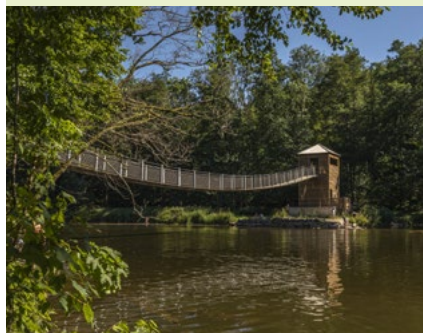
La passerelle de l'Épine, sur la Semois à Bouillon © La Graphisterie
