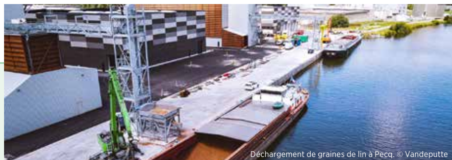
Déchargement de graines de lin à Pecq. © Vandeputte
